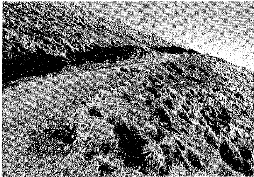
Camino entre San Antonio y San Vicente (zona que se necesita arreglo)
