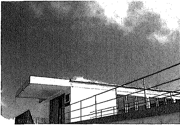
エル・アルトの浄水場
