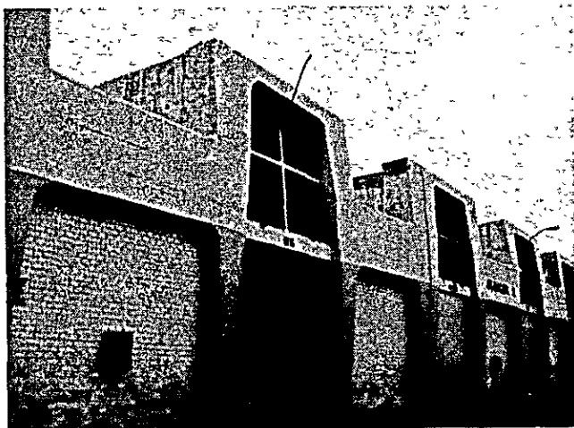
写真-17 上屋倉庫
