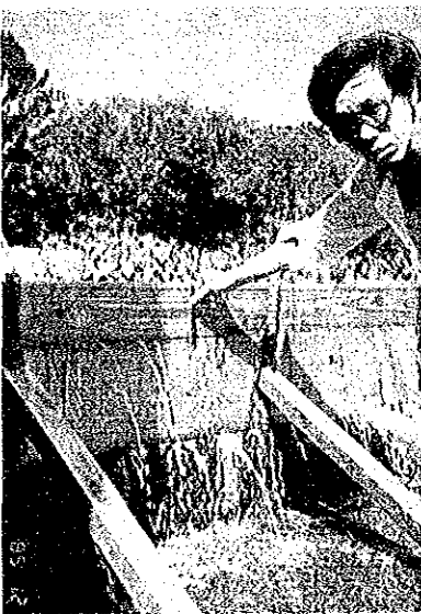
取水位嵩上げのための板
