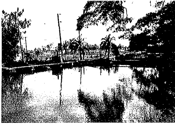
頭首工下流部約 4 km地点 スパニッシュ・タウンへの上水分水工 (上流部右岸から)
