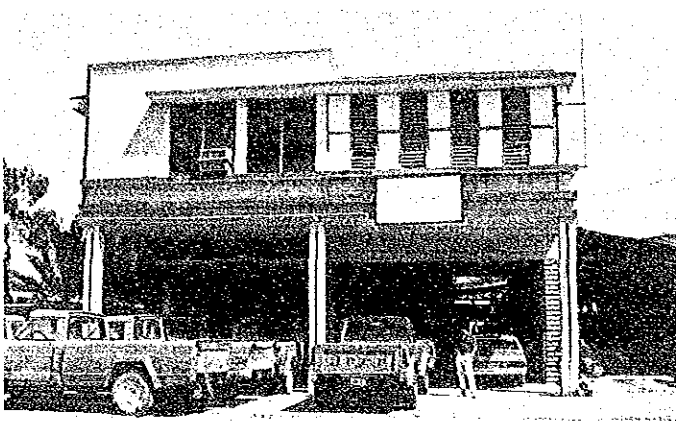
マラリア対策現場の管理事務所
