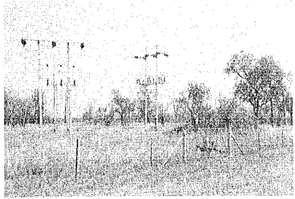
前方は養殖センター候補地電力高圧線路
