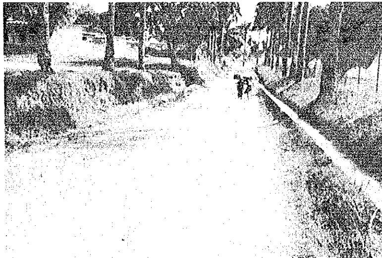
雨水によって浸食された道路
