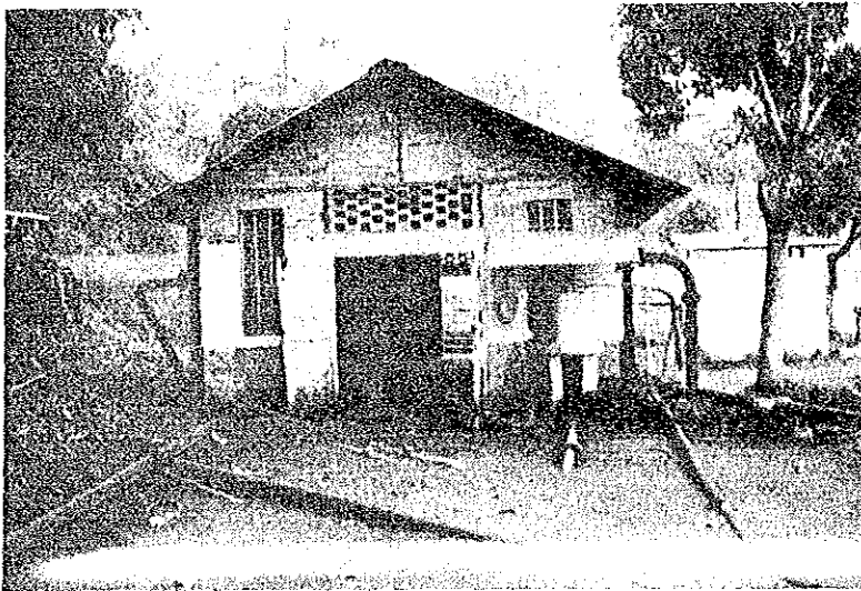
ムバンザ・ヌグング市 クスクス浄水場のポンプ小屋
