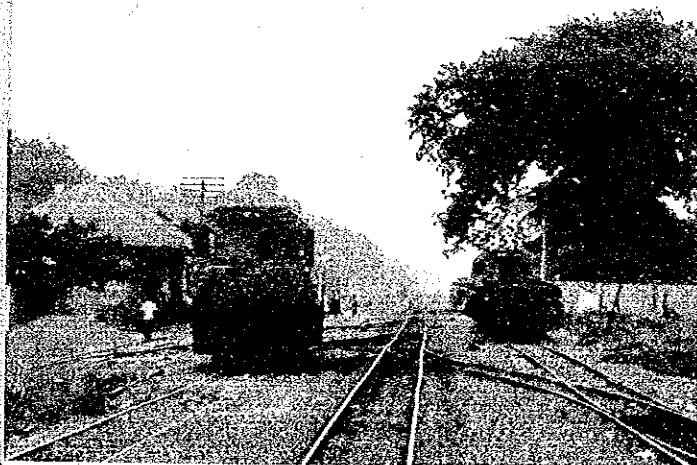
写真-12 NDOLO駅構内
