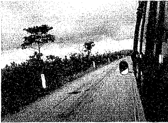
マタディー・キンシャサ間の道路状況 (I) 舗装のいたんだところはパッチングしてある
