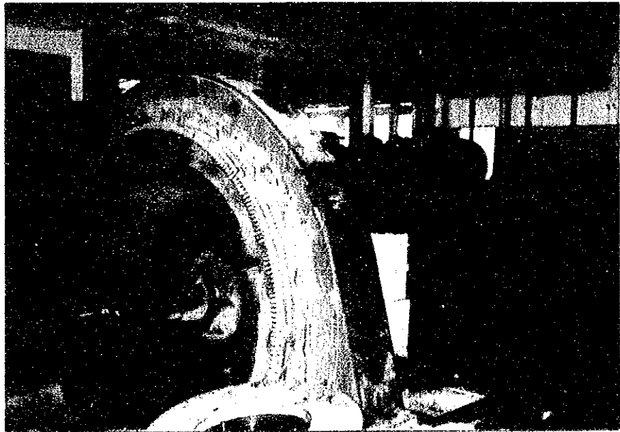
トンボ発電所 解体撤去作業中の MAN-SIEMENS機
