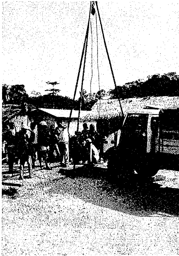
ハンドポンプの修理風景 — 中部州, ドメサセ村 —
