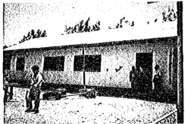
Same の District Development Office 内の の現地作業場に予定されている建物
