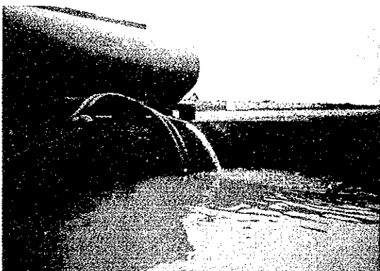
写真8 河川水貯水タンク
