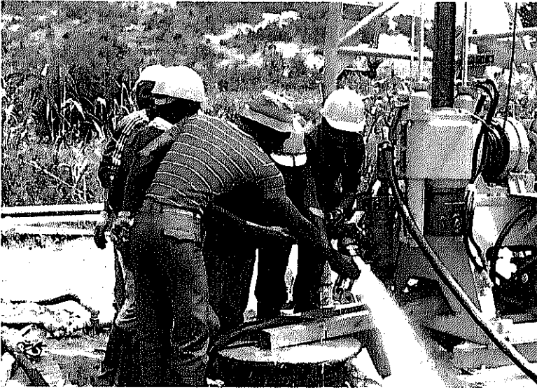
Les travailleurs se réjouissent de l'eau obtenu par forage d'essai.
