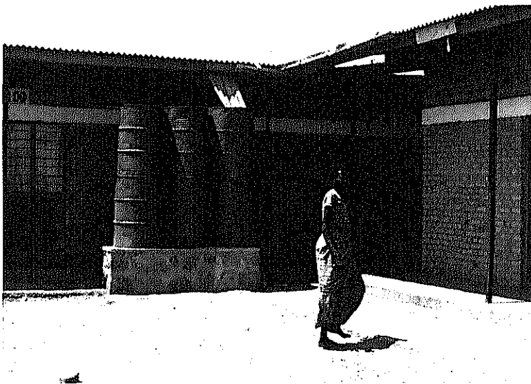
L'eau de la pluie au réservoir à Centre de Clinique de Birenga.
