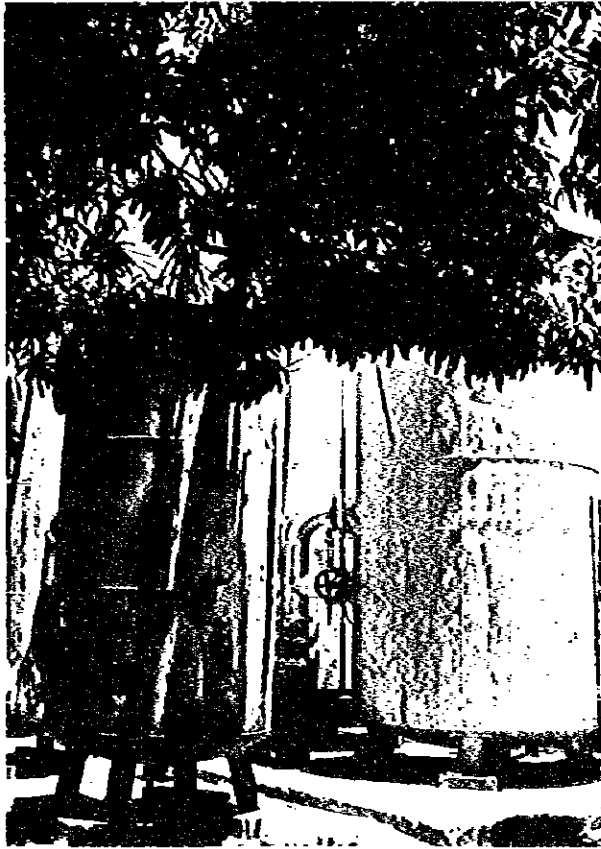
Installation de traitement d'eau de la station de pompage de la ville de Marovoy
