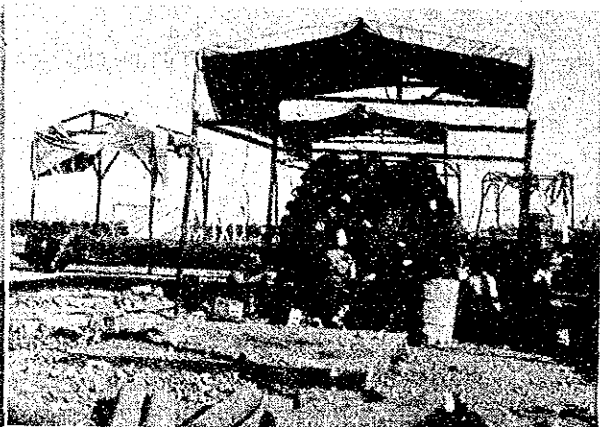
写真 3-6 補修中のカッターヘッド 硬土盤を掘削すると、2時間でカッターヘッドが摩耗する。補修作業は現地労働者が行なっている。
