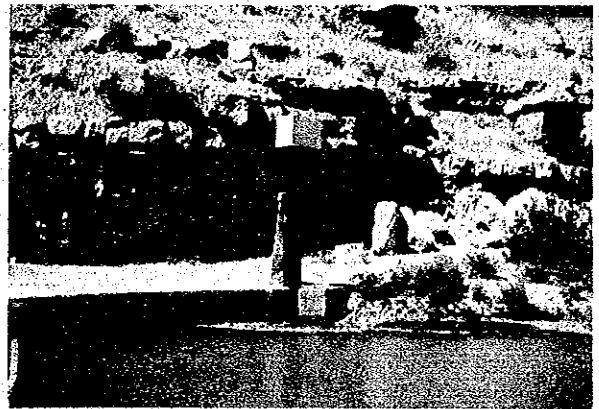
W. Wala 水位観測所、下流側(左)は床固めの堰である。施設はフロート式水位計である。
