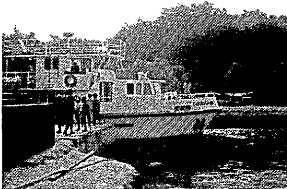
既設カンドリアン港（バース長約15m）
