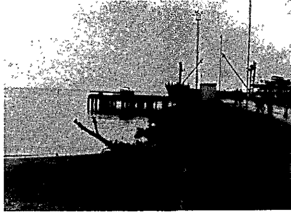
既設キンベ港（バース長約70m）
