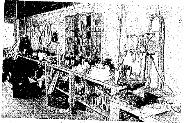
マラカル発電所修理工場
