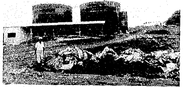
アイメリック新発電所オイルタンク風景
