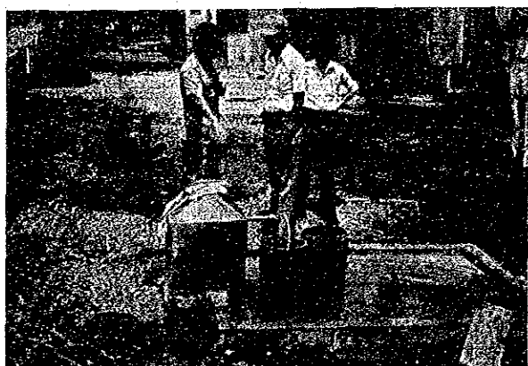
Bengkalanのパイプラインシステム (共用栓)
