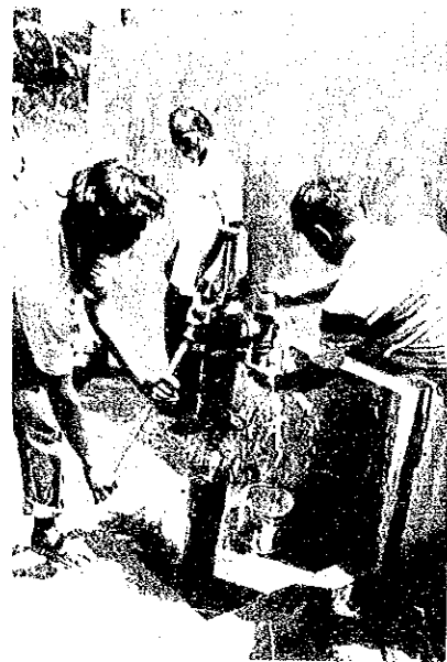
新しいポンプに呼び水を入れる
