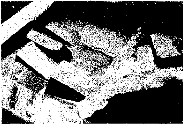
浅井戸用ろ過器(1) (レンガ, 砂, 椰子の繊維の順に詰めてある; Limau Sundai の村長宅)
