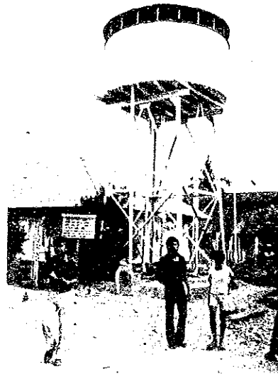
プランテーション内病院内の深井戸 ( オランダ時代の掘削, 自噴, 深さ 400 m ? )
