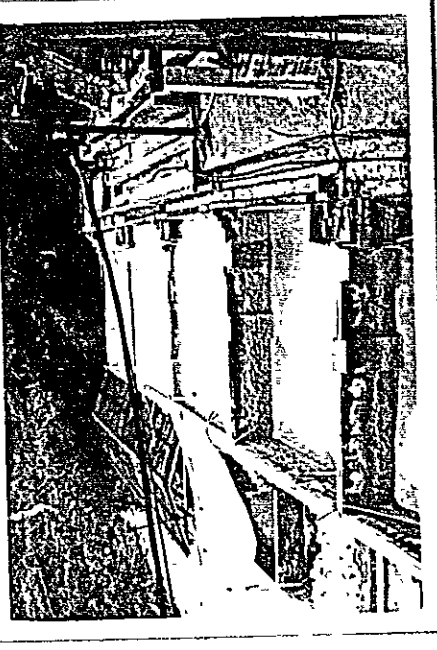
④右前方細砂分沉澱溝, 左方水鏡泥沉澱槽 後方從微砂分沉澱槽和提微砂之作業
