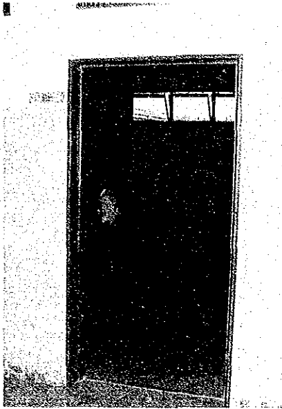
7. storage room 出入口
