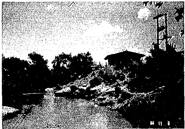
揚水かんがい用ポンプ小屋
