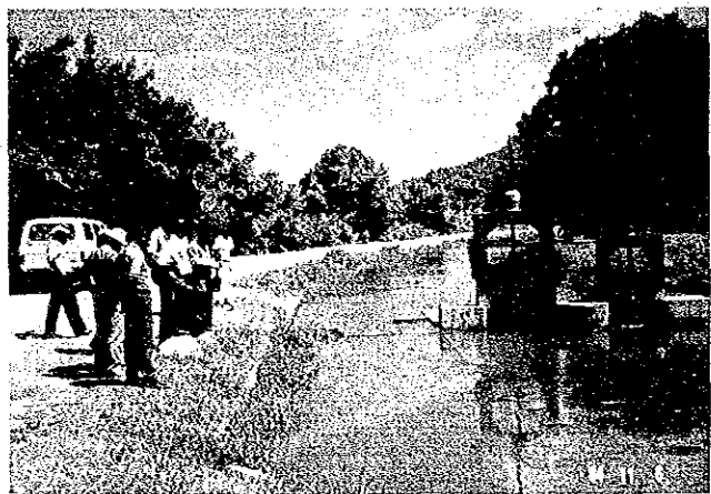
プロジェクト地区内水路
