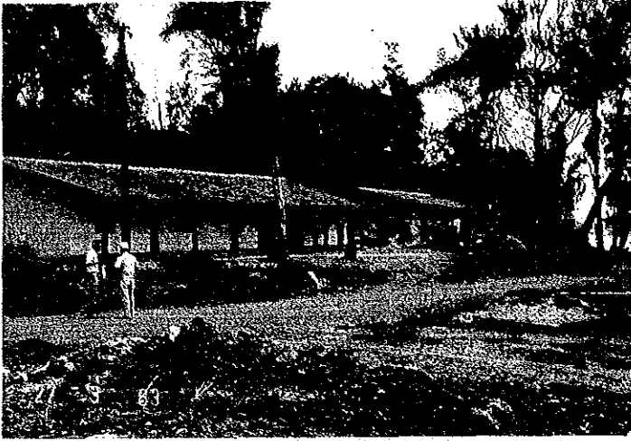
スリランカ側で建設された専門家用宿舎（完成したばかり）
