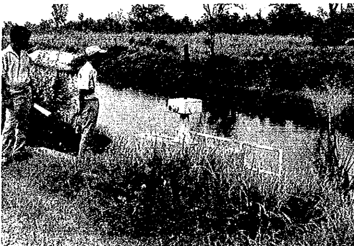
右岸幹水用水路から Block 302 へのブランチ Canal №1 の取水口
