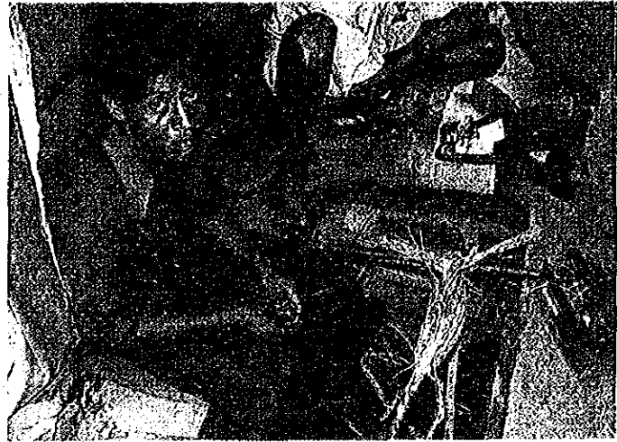
障害探索 (切分けにより障害点を探索していた。 測定器は絶縁抵抗計である。)
