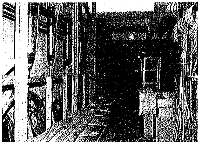
Colombo Central 局局内マンホール
