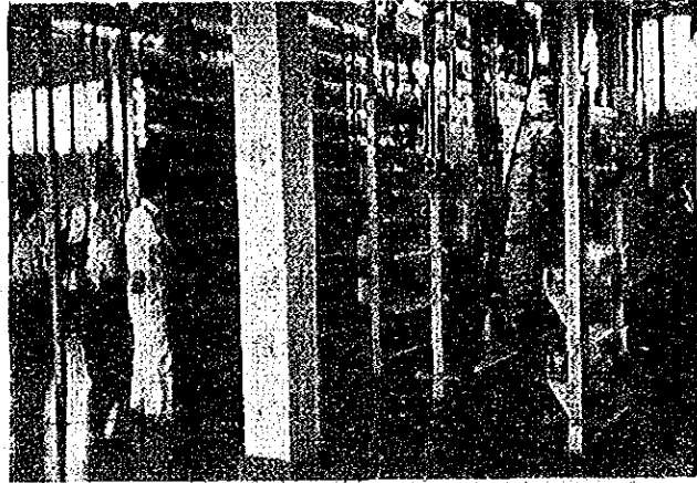
Trincomalee 移装工事
