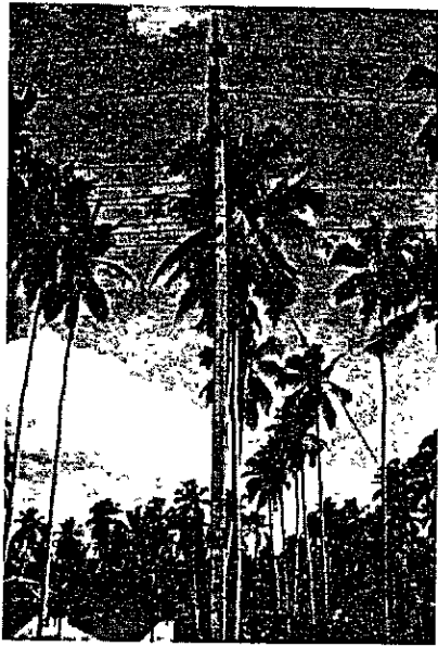
パンナラプロジェクトサイト （送電線-33,000 V）
