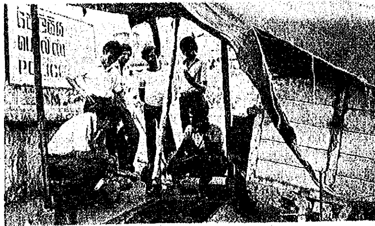
現場での作業風景
