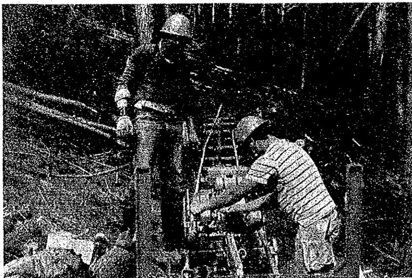
写真III-13 モノレール運搬装置の架設作業
