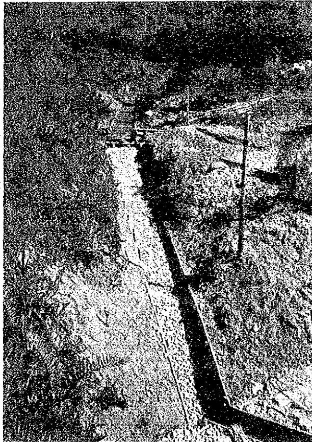
Ⅱ-10 簡易治山工の施工(水路工)
