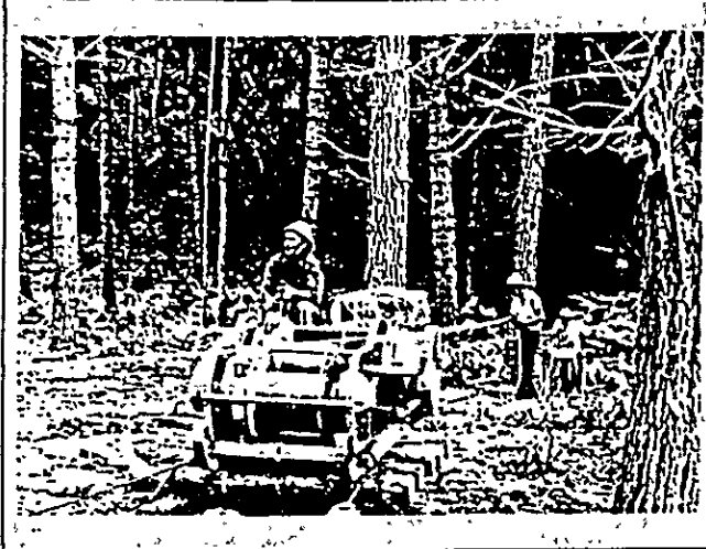
Foto 1. YARDA - Sistema Monocabo
