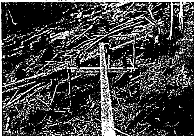
写真-30の2 モノレール運搬機の架設 (リベロン地区)
