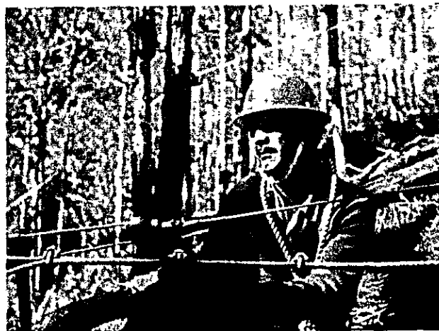
写真-10 モノケーブル集材 の架設作業（ガイ ラインの固定）
