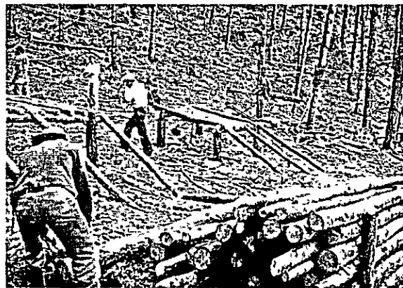
（同上林内）単線循環索の荷降し場
