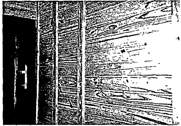
間伐材を利用した製材品の利用例（板には種々の欠点がある。）
