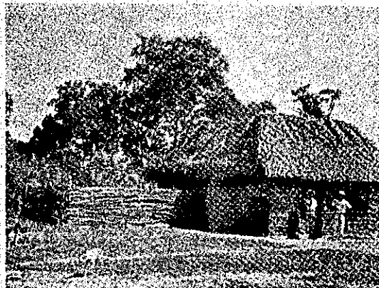
ババツスー生産地域における典型的な住宅。壁、屋根にはババツスー椰子の葉を使用、柵圍には葉柄を使用。ババツスー椰子は建築材料として最も簡便なものである。ババツスー椰子材料による建築は大工の手を借りず素人でも簡単にできる。
