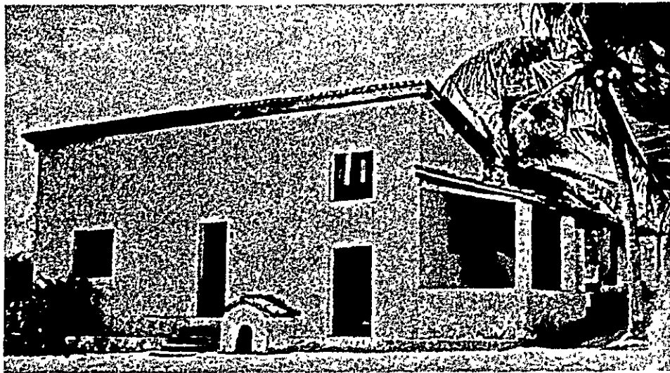
質素だが比較的快適な煉瓦造りの日本人の住居。リオ・グランデ・ド・ノルテ州ピウン入植地。
