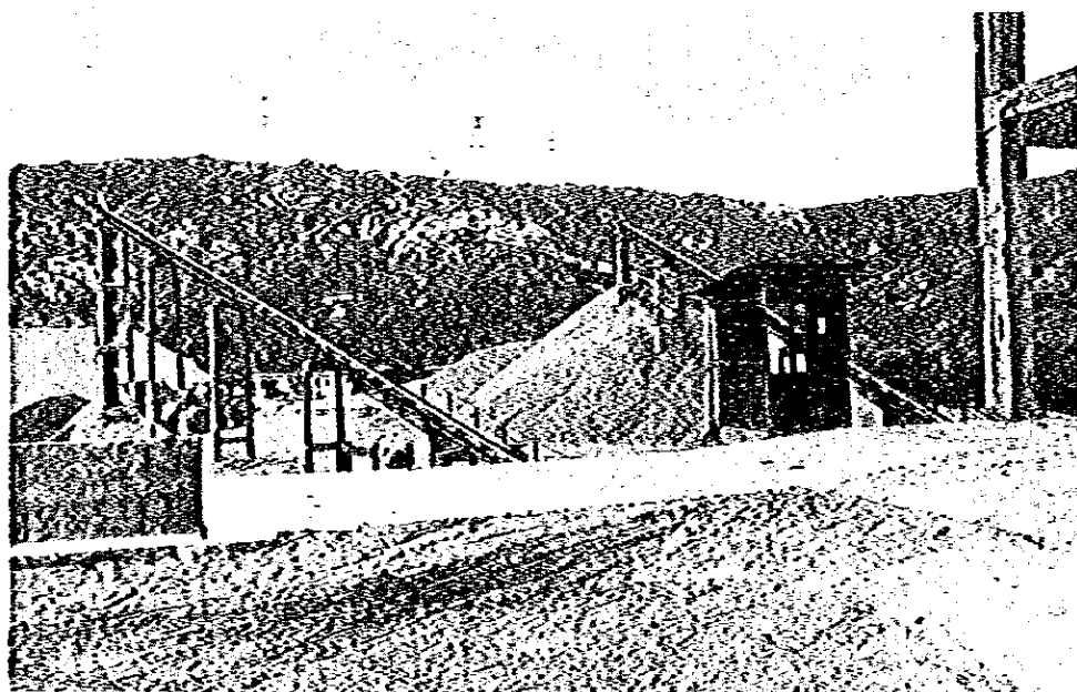
Foto 2. Pedreira Cantareira 社 碎石と貯蔵 山積みへの供給点での粉塵発生を減少するための塔がある。
