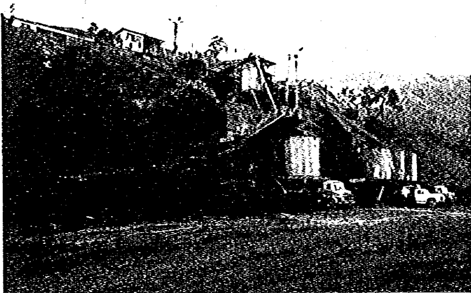
Foto 17. Itaminas (鉄) 鉱山の選鉱場，アキンス分級機からの半分は \frac{1}{4} 以下で、販売されず貯蔵している。(左のサイロ)
