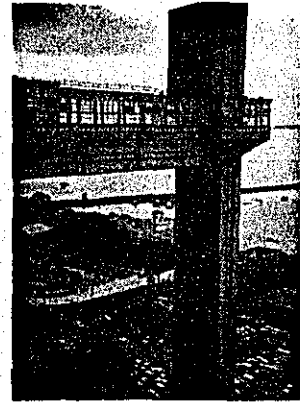
上街と下街の60mを結ぶラセルダエレベーター
