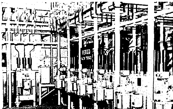
電気工場内部
