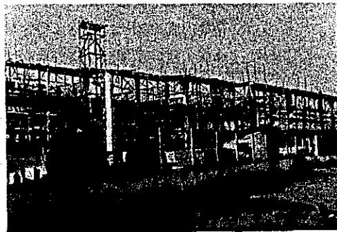
(7.3図 建設工事中の MOTORADIO 社)
