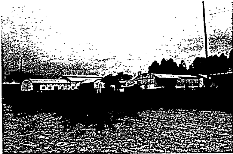
精棉工場全景
