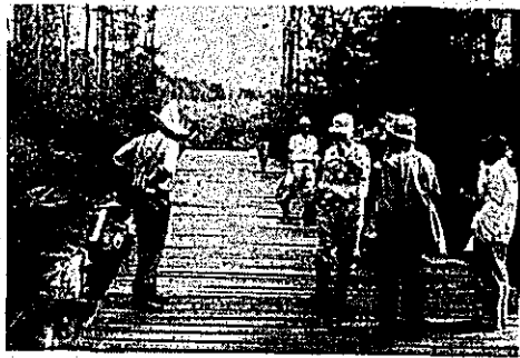
移住地の道路建設 (アマゾン第2トメアスー移住地)
