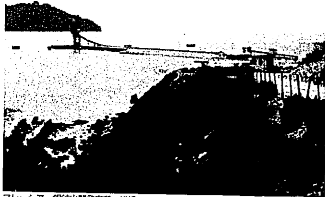
マレーシア 鉄鉱山開発事業 橋構
