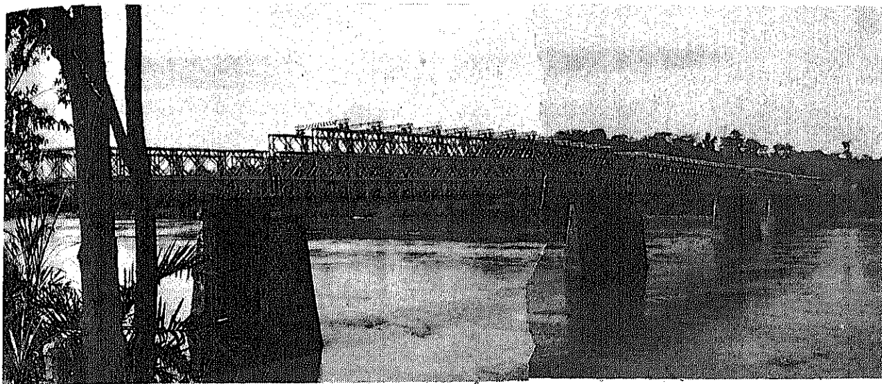
Photo. 9. Pont de la rivière Lindi à PK 37 (Voie unitaire du type de Pont Bailey à poutre en treilles)
