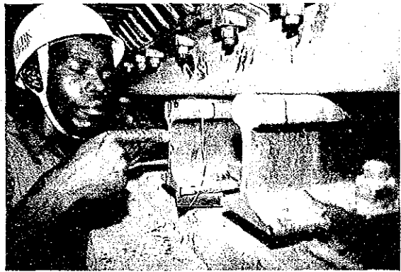
伸縮装置 橋台付レールのずれ
