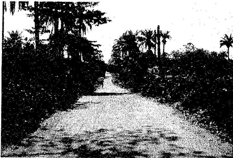
現道の状況 (Makeni より 5 Km 付近)
