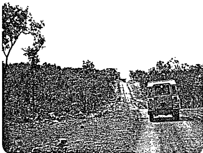
写真-7 2159号線 現道改良中部分
