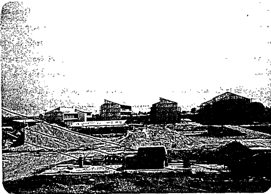
建設中の宿舎（カンベンセン普及研修センター）
