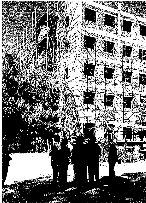
中国非鉄金属鋳業試験センター（建設中）
